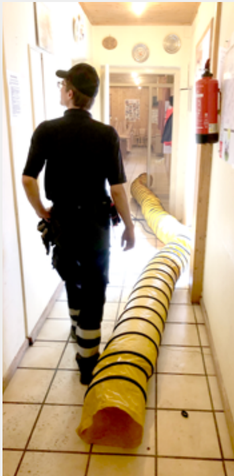
Trocknungsarbeiten nach dem Unwetter.
